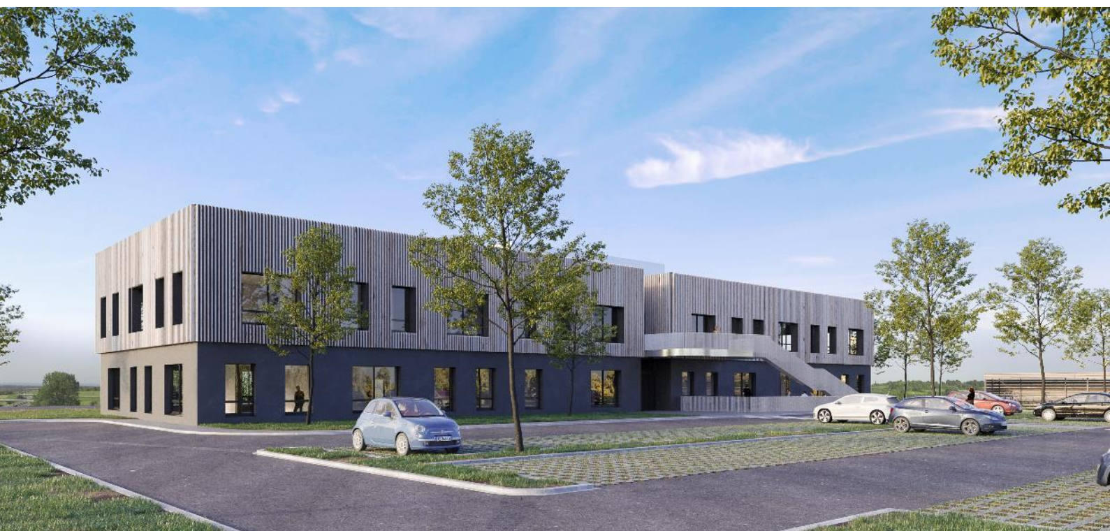
Fig.: En haut: à gauche: façade Sud (chantier); à droite: escalier extérieur (chantier). Au milieu: façade Nord (chantier). En bas: façade Nord (projet).
